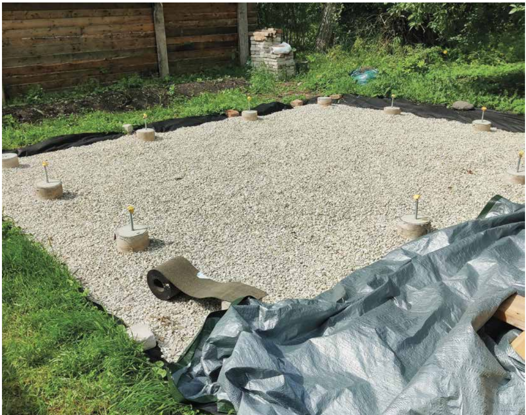
Illustratsioon 50. Ettevalmistatud postvundament.
