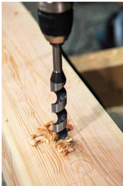
Illustratsioon 47. Tapipesa ette puurimine ja peitliga välja lõikamine (B).
