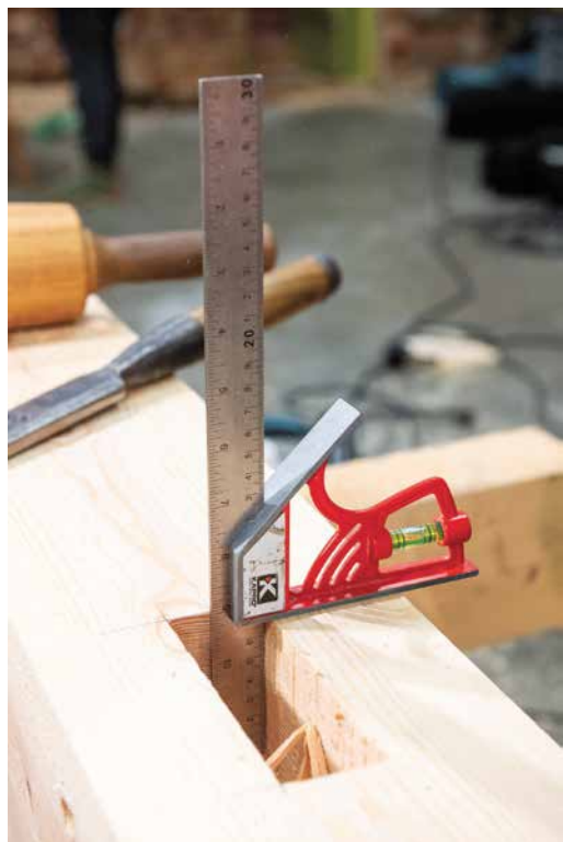
Illustratsioon 22. Tapi sügavuse mõõtmine universaalse nurgikuga.
