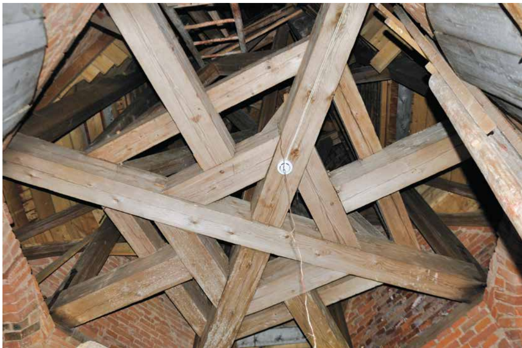
Illustratsioon 1. Kolga-Jaani kiriku torni pruss-sõrestikkonstruksioon.
