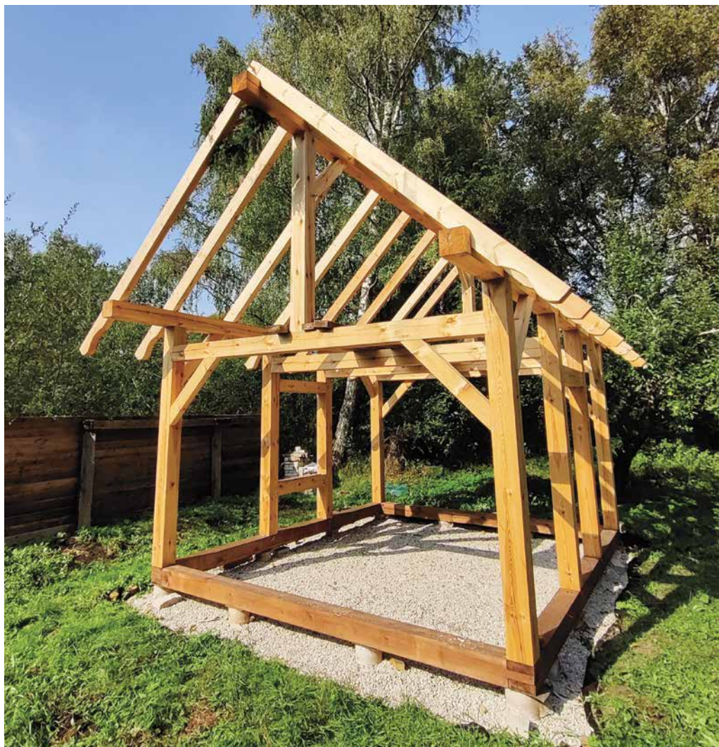
Illustratsioon 53. Püstitatud valmis karkass.
