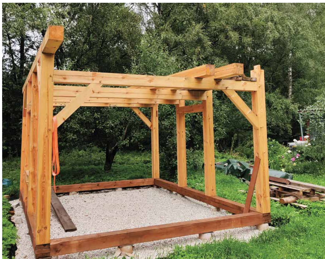
Illustratsioon 51. Ülemise vöö paigaldamine.
