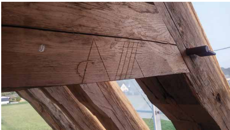
Illustratsioon 42. Tähistatud detailid ajaloolises konstruktsioonis.
