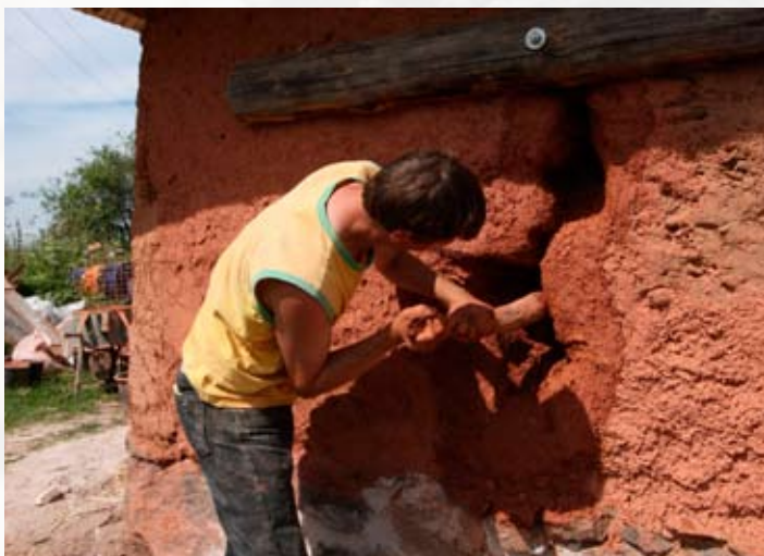
Saviseina läbiva lõhe parandamine
