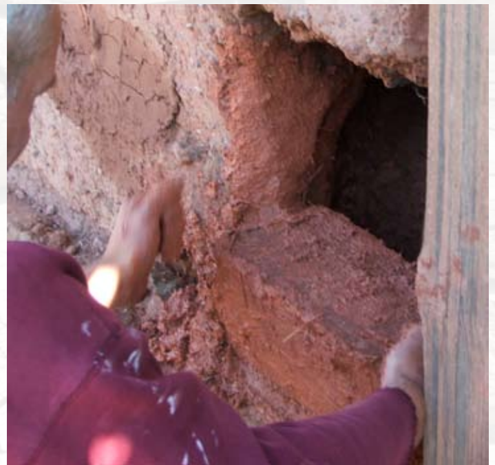
Väljakukkunud seinuosa parandamine plonniga
