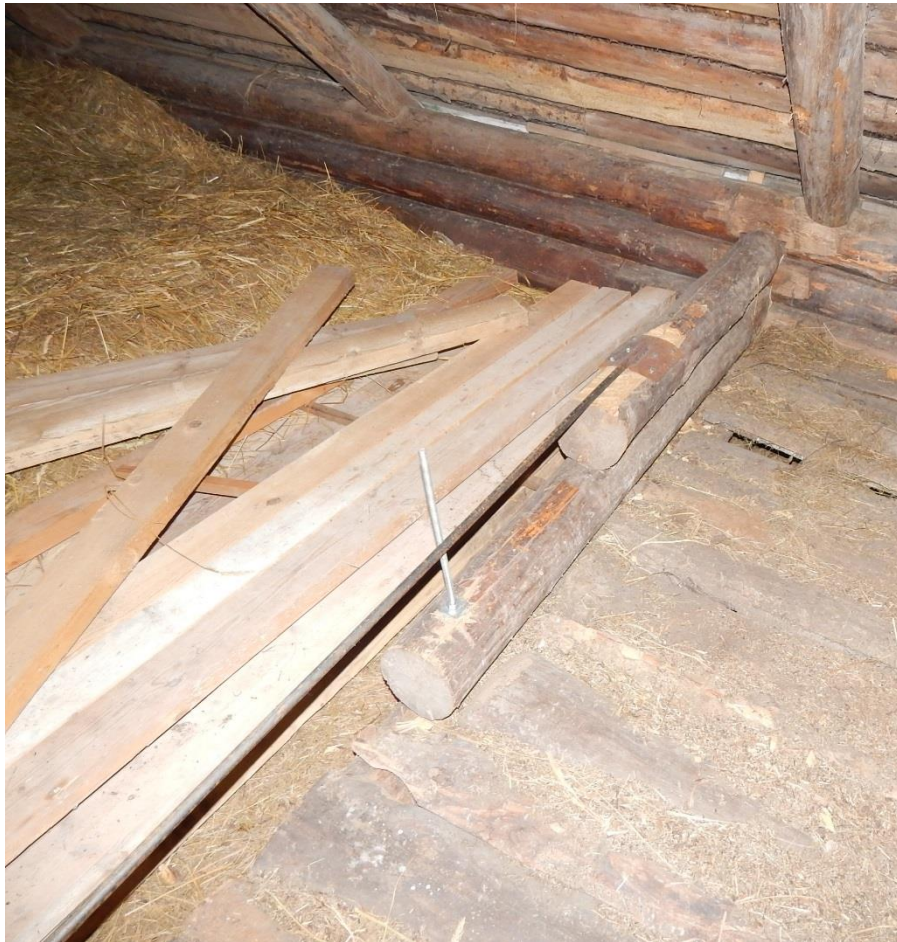
Läbi saetud tõmbetalad ja terastõmb
