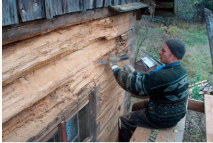
Palgi kahjustatud osa eemaldamine seinalt peitliga.
