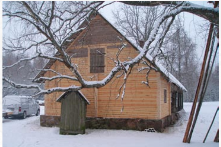
Hooneosa lahti võttes selgus, et otstarbekam on asendada kogu palkosa. Vanast talli osast sai alles jätta ainult ülemised viilupalgid.
