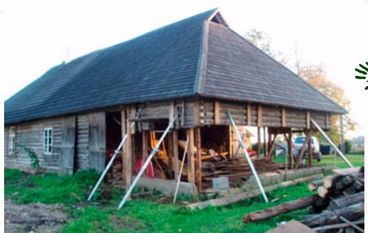
Rehealuse 8 alumist palgirida vajasid vahetust.
