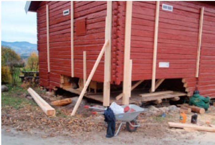
Aida seinad on prussidega ajutiselt stabiilsemaks muudetud, et saaks teostada vajalikke palgivahetustöid.
